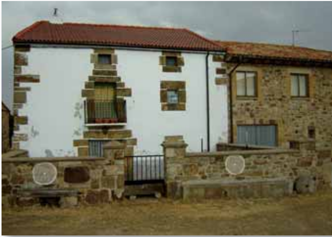
Fig.2. Casa con tres muelas en Cubo de la Sierra.
